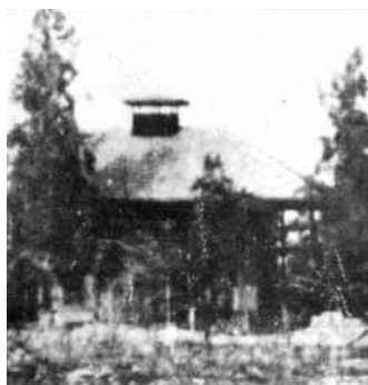
איורים 12, 13, 14 (מימין לשמאל): בית וילנד, שלבי בנייה שונים; תא התצפית על הגג והמרפסת ההיקפית נוספו לאחר שהושלמה בניית בית הבוץ (באדיבות ארכיון שדה-אליהו ומשפחת וילנד, שטוטגרט)
