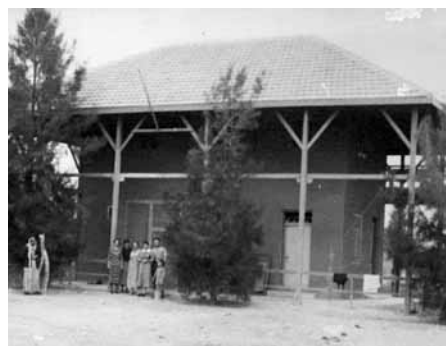
איורים 12, 13, 14 (מימין לשמאל): בית וילנד, שלבי בנייה שונים; תא התצפית על הגג והמרפסת ההיקפית נוספו לאחר שהושלמה בניית בית הבוץ (באדיבות ארכיון שדה-אליהו ומשפחת וילנד, שטוטגרט)
