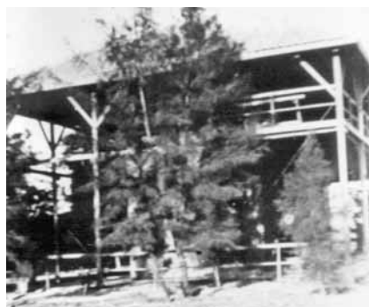
איורים 12, 13, 14 (מימין לשמאל): בית וילנד, שלבי בנייה שונים; תא התצפית על הגג והמרפסת ההיקפית נוספו לאחר שהושלמה בניית בית הבוץ (באדיבות ארכיון שדה-אליהו ומשפחת וילנד, שטוטגרט)
