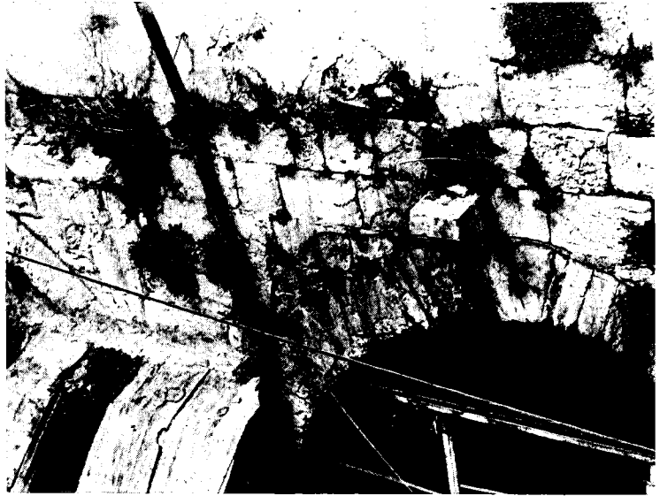
איור 5: הקונסולות הבולטות מחזית מיבנה הקמרונות
